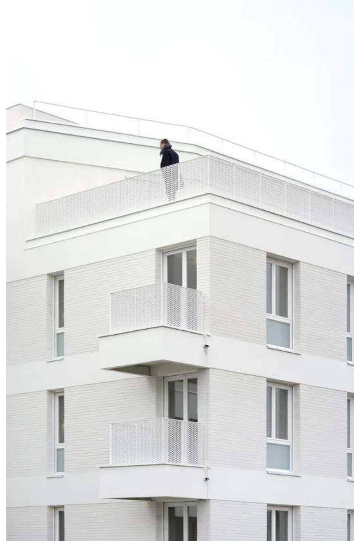
MARCAÇÃO LAJES USO DE COR E PLANO
