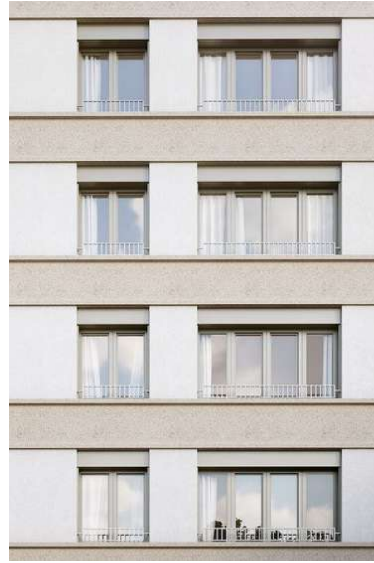
PLANO DE VÃO E CAIXA DE ESTORE RECUADO COM CONTRASTE DE COR
