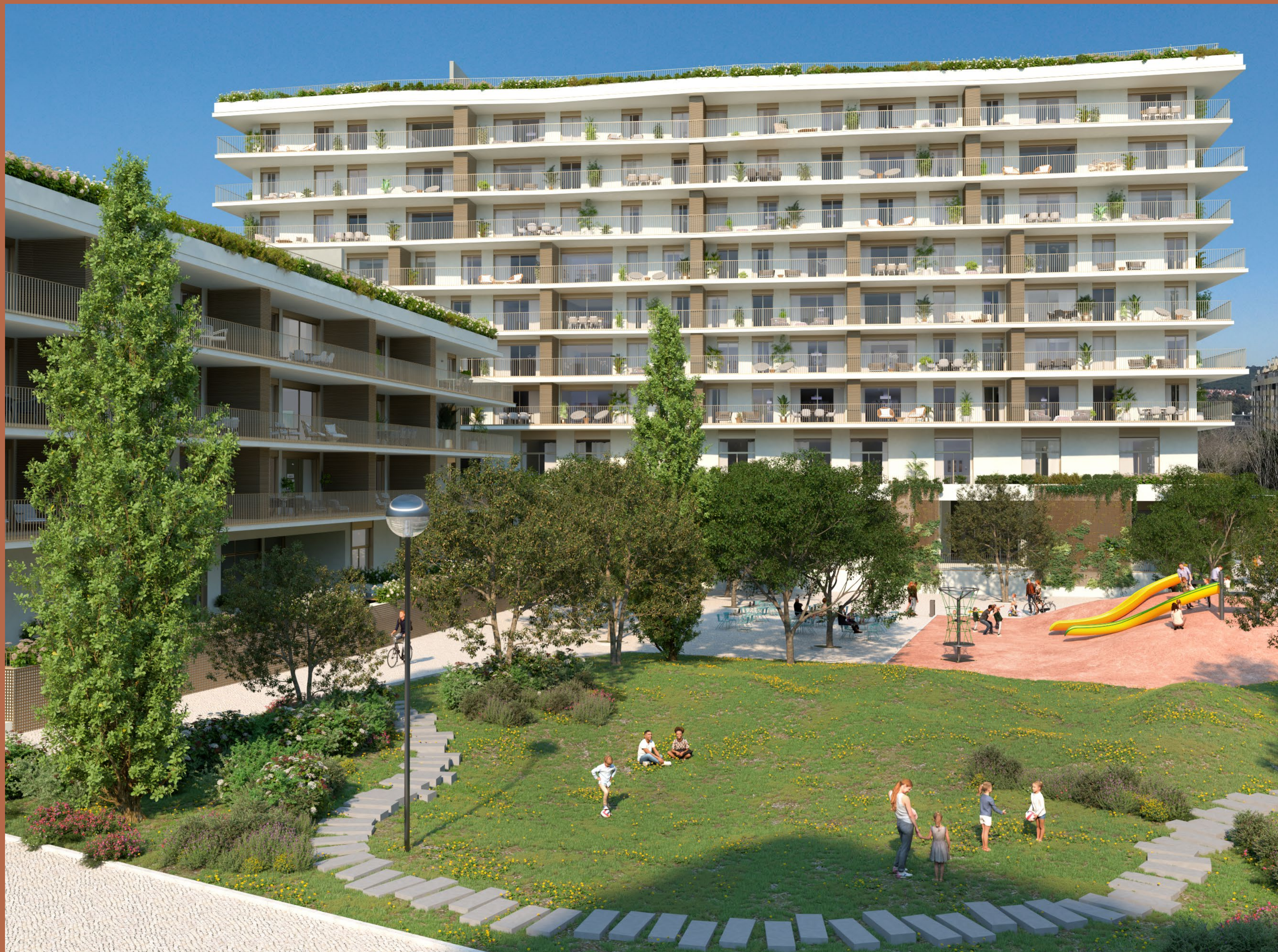
Edifícios E e F.
